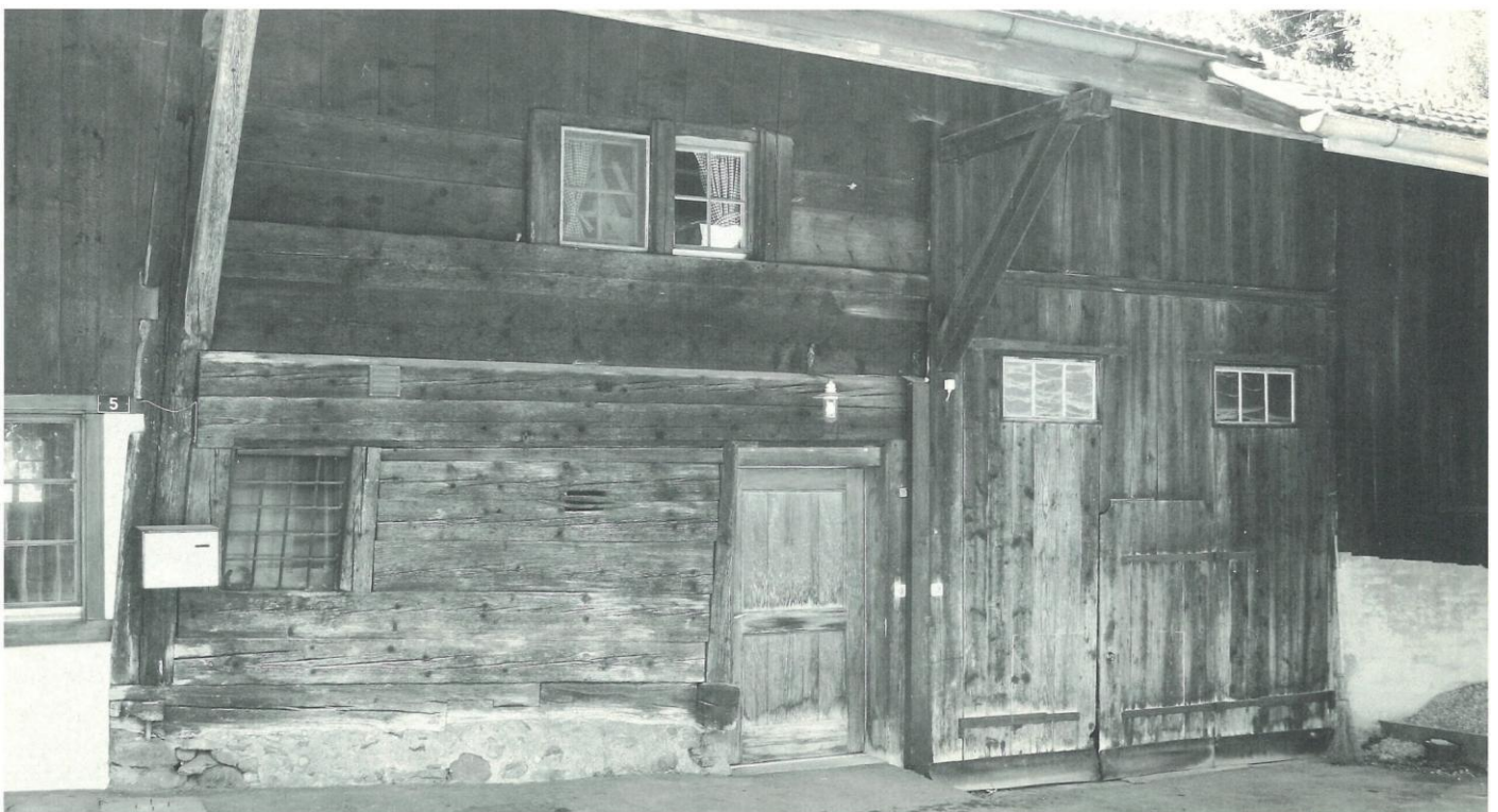
Ältester Bohlenständerbau in Gündisau aus dem 17. Jahrhundert. Der Lehrer, der darin 1813 wohnte, hiess Hs. Jakob Gubler. (Jürg Sudan, Gündisau)
